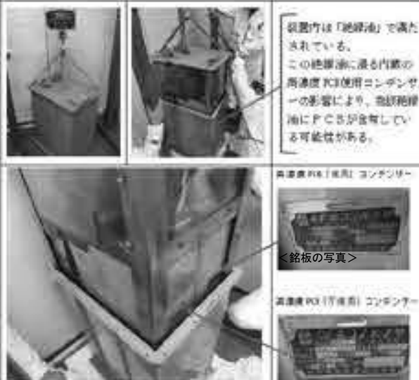
装置内のコンデンサーの確認作業の様子
