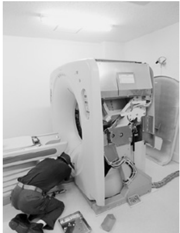
装置解体風景
