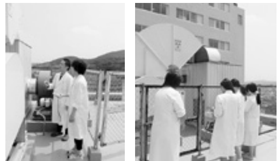
図4. 放射線施設：排気設備の見学・説明 (へパ・プレフィルターなどにより放射性物質を捕集していることを説明)
