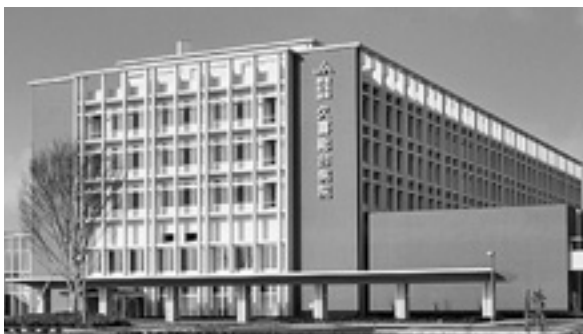
図1：久喜総合病院 外観
