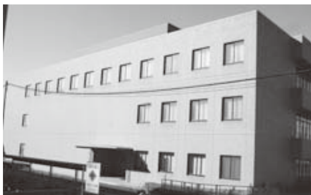
図1：第一研究棟全景
